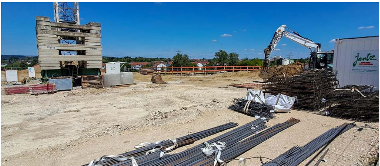
Bagger rollen und schweres Gerät ist im Einsatz: Auf dem Konversionsgelände in Reutlingen-Rappertshofen entsteht aktuell das neue Quartier.Wohn.Haus (QWH).
